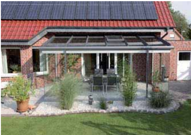
Geschmeidige Anpassung an das Haupthaus Harmonischer Anschluss an die Form des Hausdaches. Glas-Schiebetüren sorgen für maximale Transparenz.
